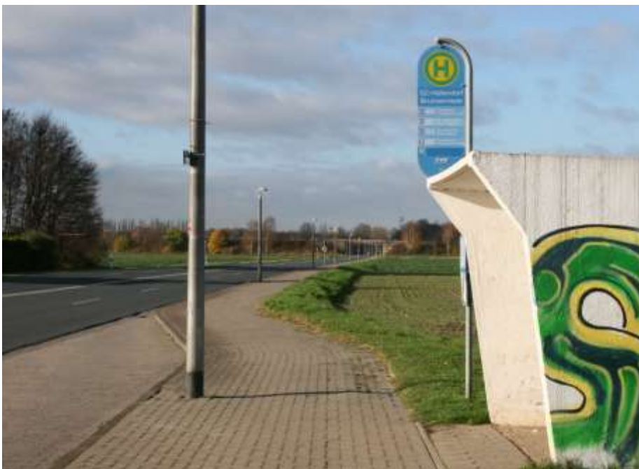
Die Laternen auf der linken Straßenseite wurden entfernt. Die Laternen auf der rechten Seite wurden gekürzt und umgerüstet. Foto:Horst Rösler
